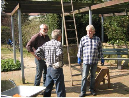
Hans-Peter Thielker, Rainer Fischer und Günter Arndt besprechen die Abbrucharbeiten
